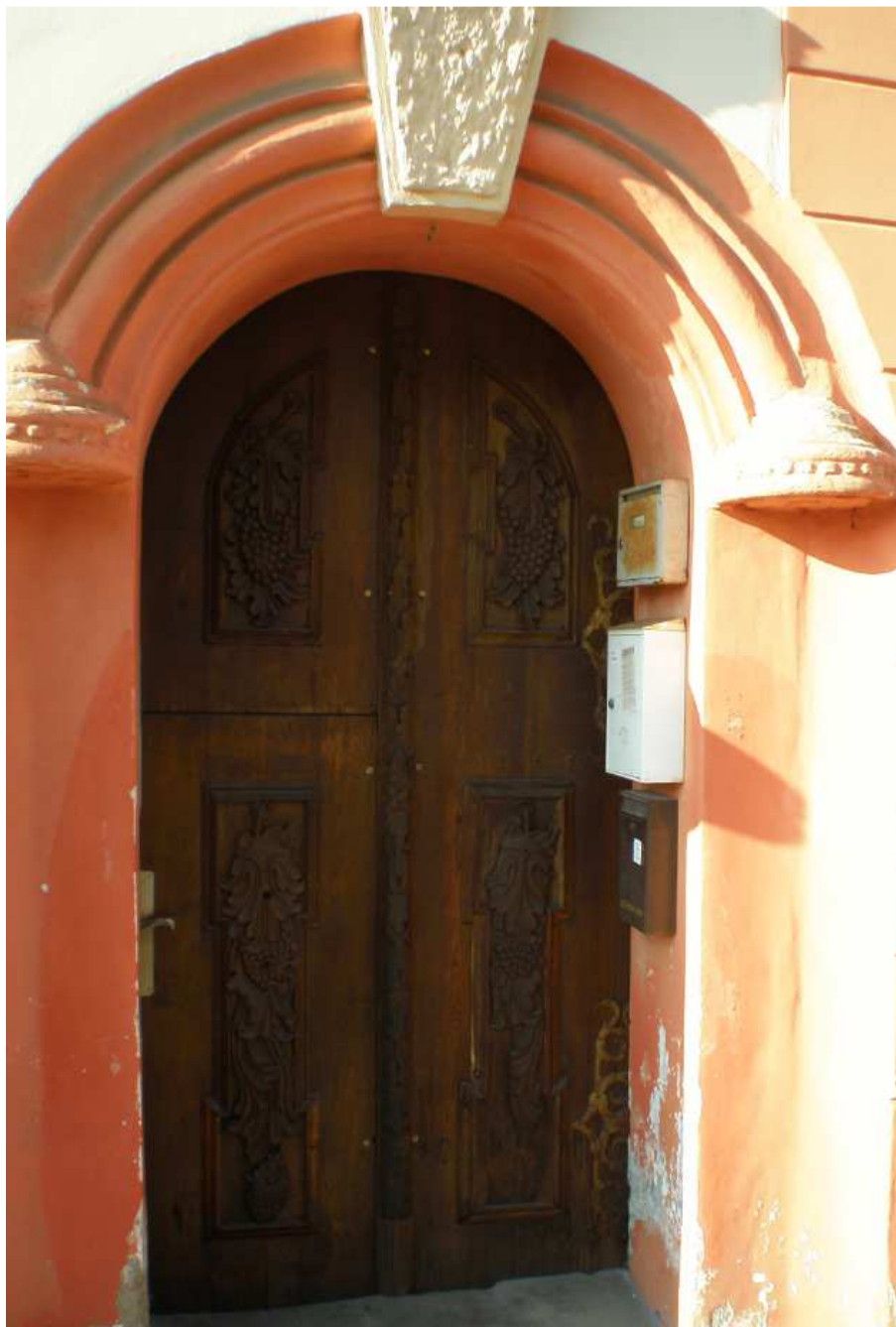
Původní VCHODOVÉ DVEŘE (ranně barokní) cca 1220/2560 mm 1 KS odborné restaurátorské ošetření (konzervace), včetně dobového kování.
