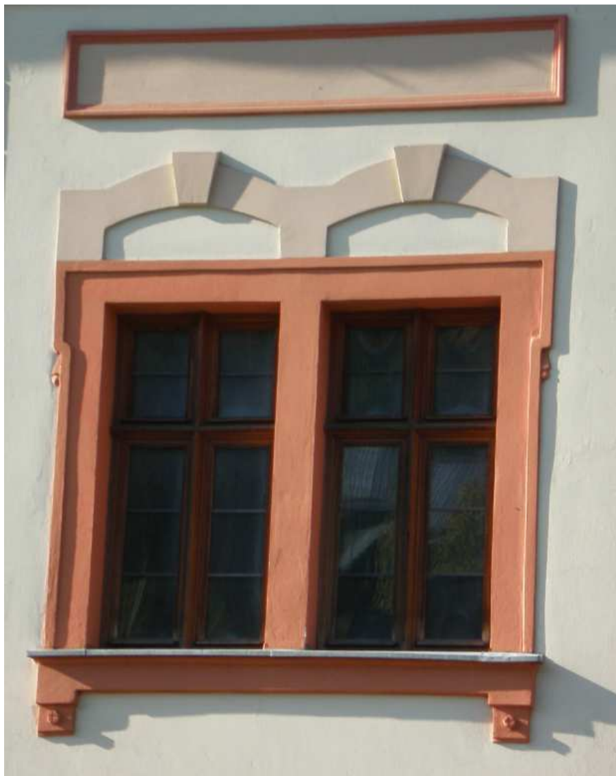
SDRUŽENÉ OKNO jednotlivé okno ČTYŘKŘÍDLOVÉ zdvojené 890/1670 mm 9 KS - obnova nátěru
